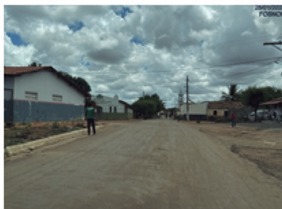
FOTO 5.4.7.2 Entrada da comunidade, vindo a partir da BA-052, com via pavimentada.
